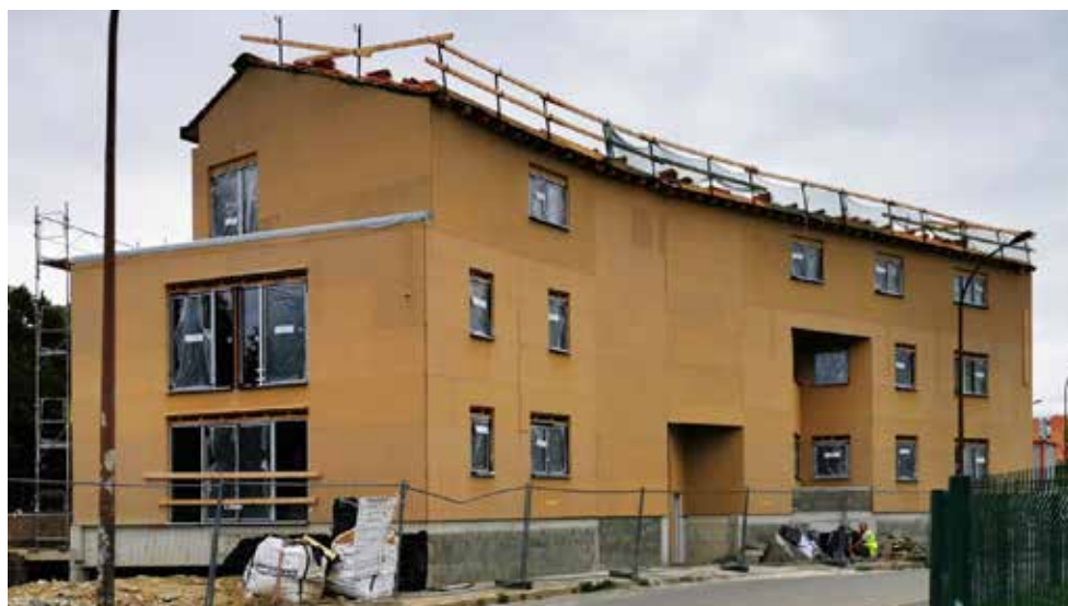
Une structure bois/béton avec des interfaces et des coupes complexes, parfaitement ajustées sur place par les charpentiers. L'ensemble est entièrement isolé par l'extérieur en fibre de bois.
