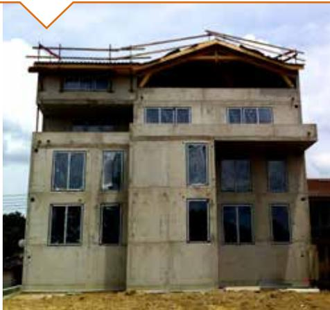
Les murs en béton de 200 mm d'épaisseur sont isolés par l'extérieur en laine de roche ou en polystyrène.
